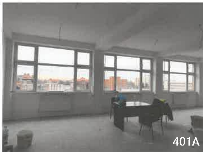
Sala 401 A - SE EXTINDE CU INCA O TRAVEE
